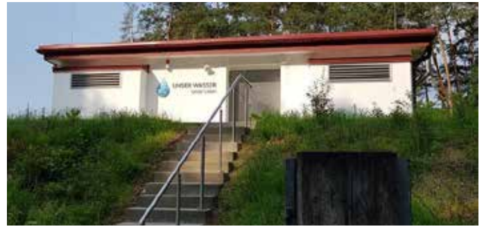
Wasserwerk Offenstetten Ostansicht
