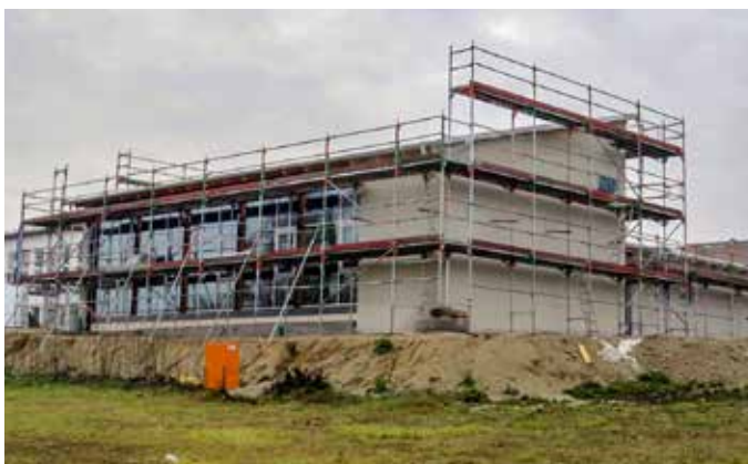
Anbau im Dezember 2018
