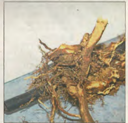
Eine Wurzel war derart um ein Rohr gewachsen, dass am Ende kein Wasser mehr floss – ein Fall für den Bereitschaftsdienst.
