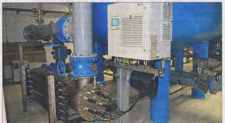
Das aufbereitete Wasser wird in dieser Vorrichtung mit UV-Licht bestrahlt, um mögliche Keime abzutöten. (Fotos: jp)
